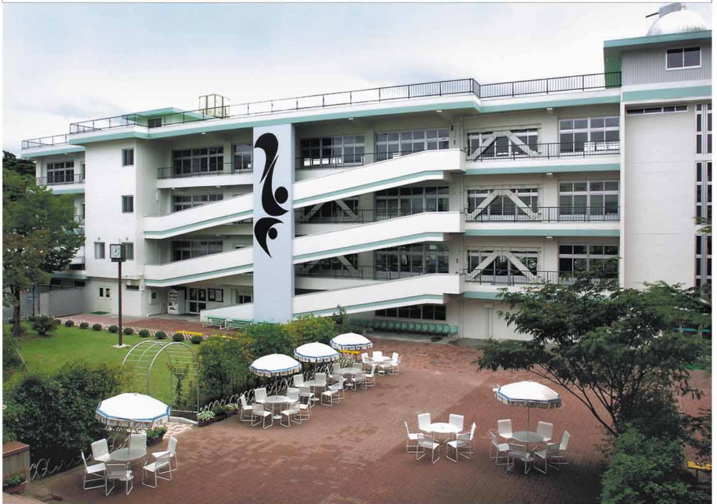
耐震工事終了の62年館
