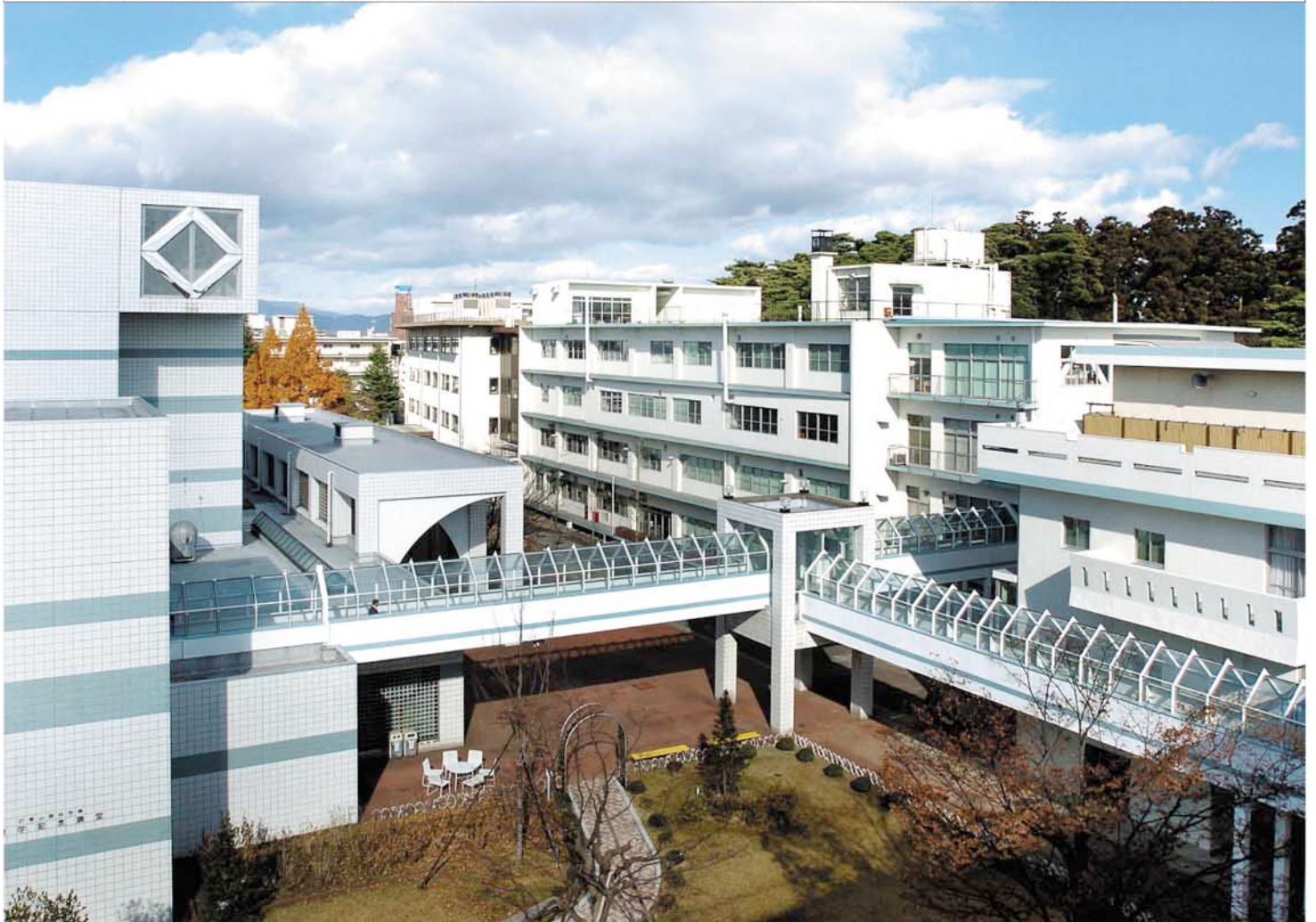
62年館屋上より見る耐震構造校舎の北東部
