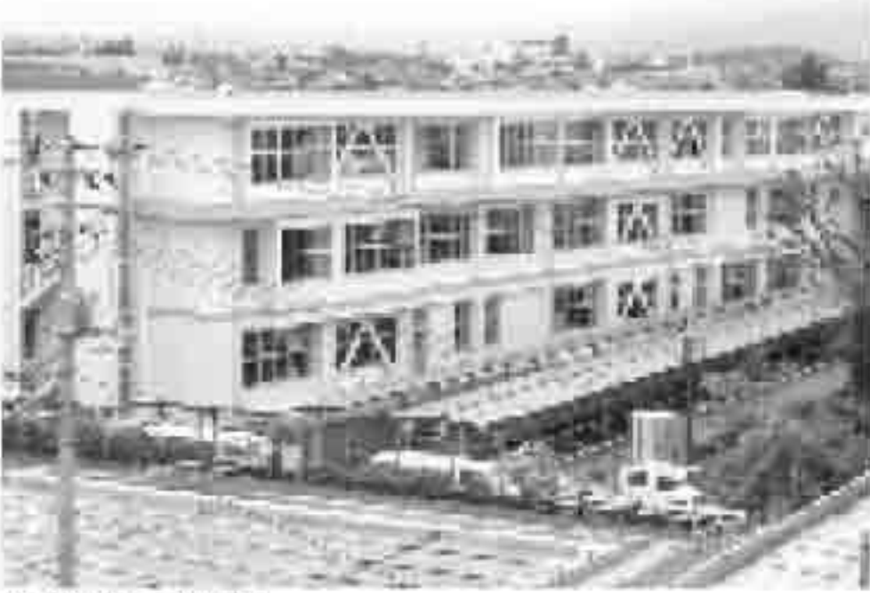
補強された高校東棟
