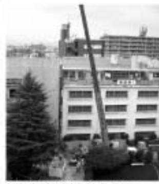
敷地内で柱や基礎の耐震補強工事
