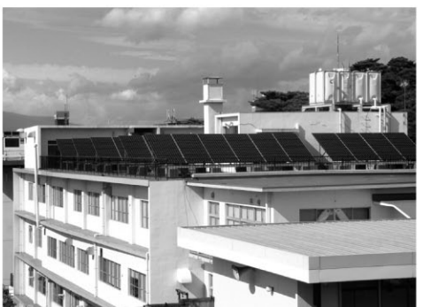
家政学館屋上に設置された太陽光発電設備
