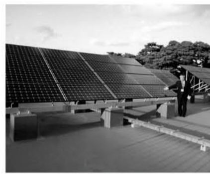
増設された太陽光パネル
