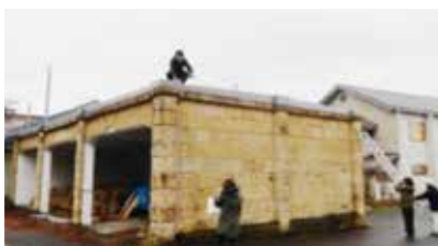
③旧高畠駅舎群建物測量調査
