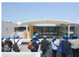
建設現場見学会
